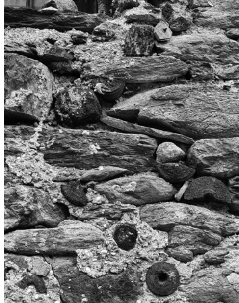
Saint-Jacques-des-Allemands, esempi di reimpiego degli scarti di tornitura nelle murature degli edifici
